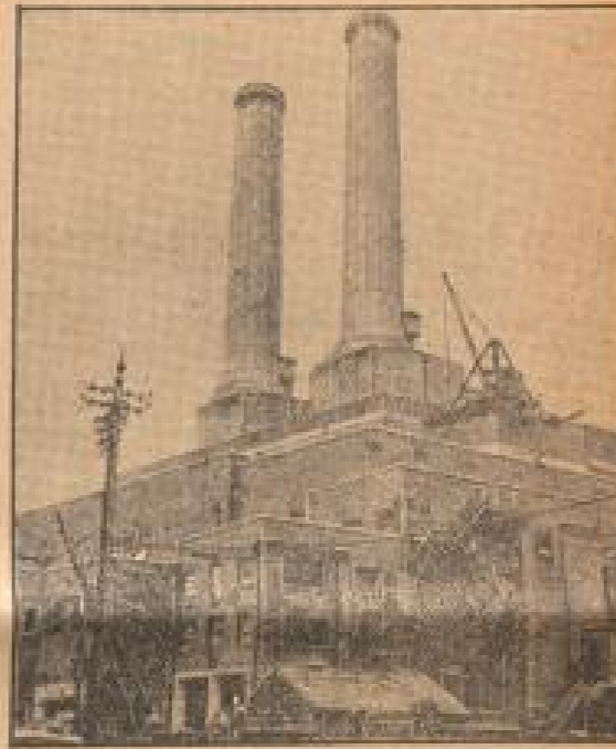
Ein neues englisches Großkraftwerk. Unter einem Turmwerk von 200 Metern Höhe ist in Füssen im Schwabenland ein Großkraftwerk errichtet worden. Das Turmwerk ist mit einer Leistung von 100000 Kilowatt ausgestattet. (München, 1936)
