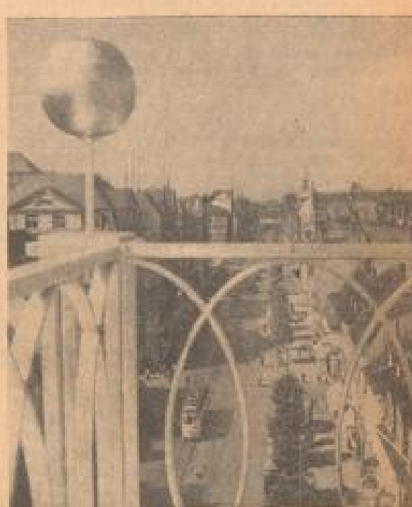
Blick vom Dach des Plankenturmes in Richtung Rheinstrasse (Foto: M. Schaeffer)
