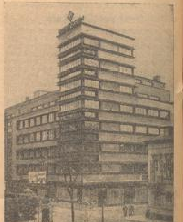
Das Mannheimer Turmhaus, dessen Innenräume auf Eingang umgebaut wurden
