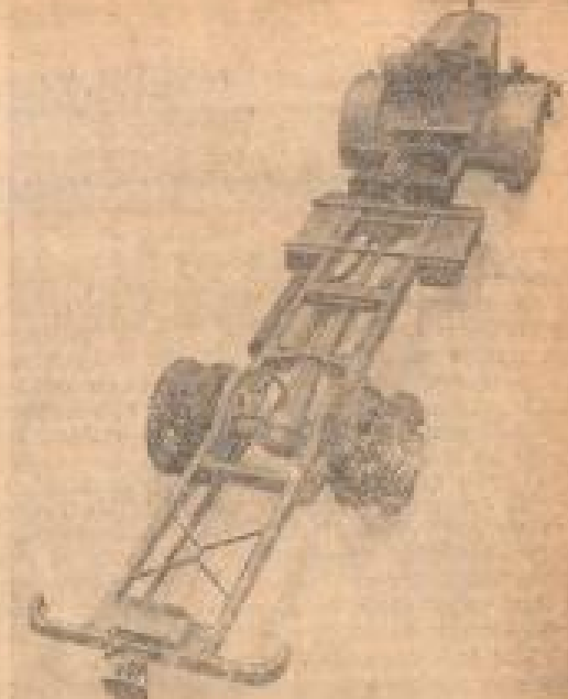
Krupp-Omnibus-Fahrgestell OD 55 N 212 mit 125 PS-Dieselmotor
