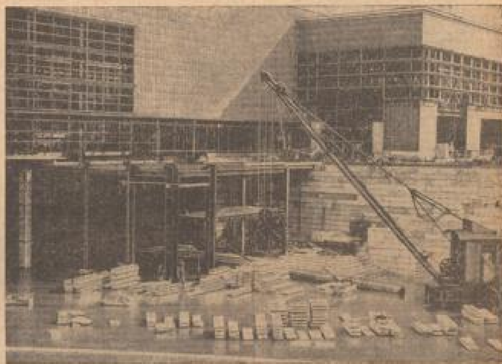
Die Arbeiten am Seilfähren Bauwerk für die Weltausstellung werden infolge des Hochwassers der Rhein erheblich verzögert.
