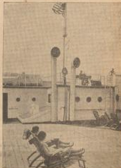
Kein Schill — sondern ein Dachgarten
