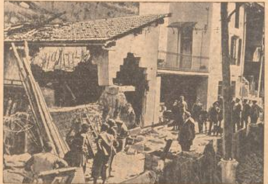
Ein Berg droht ein Dorf zu verschütten
