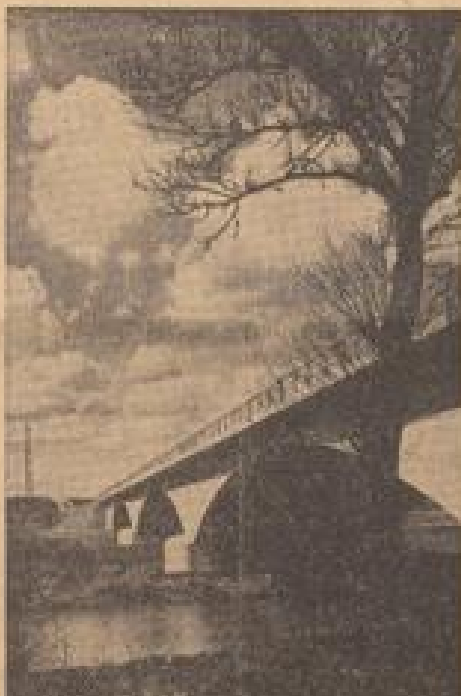
Seit der Machtübernahme wurden über 600 Brücken für Straßen erneuert und über 3400 Straßenbrücken erbaut.
