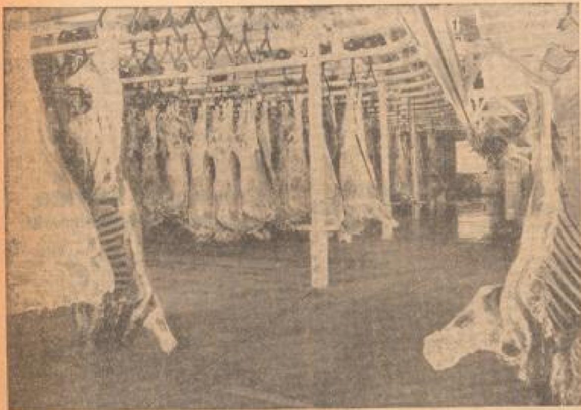
Die Grotzkopf-Vorkühlabteile, die beim Umbau wesentlich vergrößert wurde.
