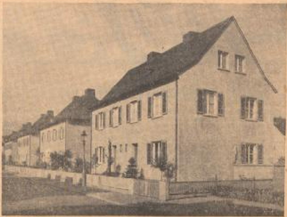
Gasfab-Häuser in der Robert-Blum-Straße im Altonaer Gebiet (2 Fotos Krögel)
