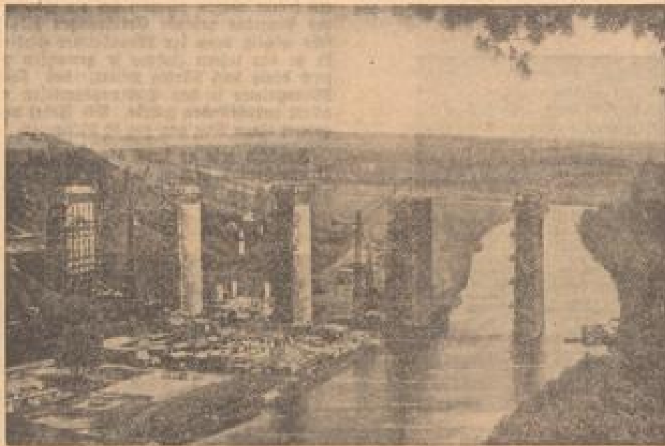
Autobahnbrücke, die 63 m hoch über den Fluß führt, wird geschaffen
