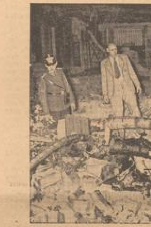
Heber stellt die bei dem letzten Unwetter zerstörte Mauer wieder auf. Die Mauer wurde im letzten Unwetter zerstört und ist jetzt wieder aufgebaut. (Foto: Bildzeitung, Jänner-Beilage, S. 1.)
