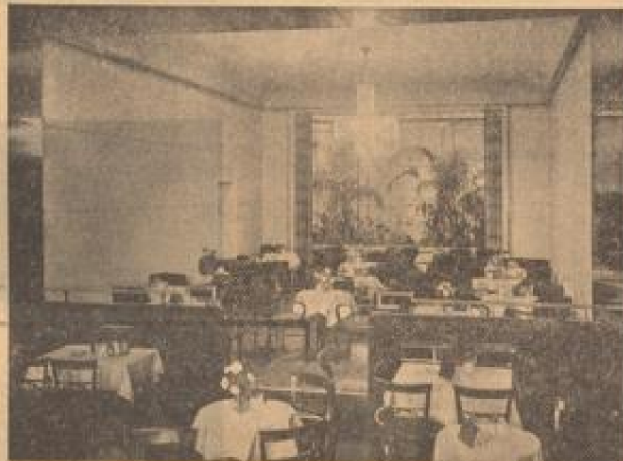
Stolz und geschäftlich ist der große Hofraum des neuen Kaffeehauses an den Planken geworden. (Foto: Heilmann)
