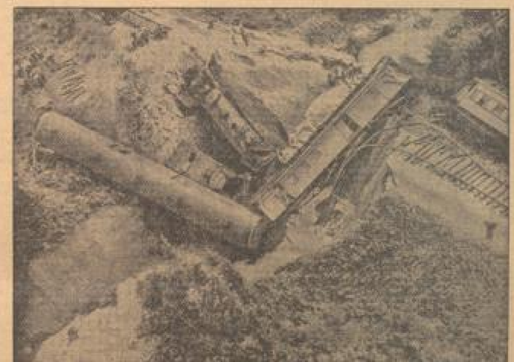
Eine Brücke war völlig unterwaschen
