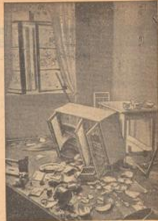
Bei Untergrabung loten die Kisten für einen Hofbau angesetzt und begann eine Schicht auf Grund des Gebietes. Angehörigen der sudendeutschen Ordnungsdienst gelang es, im Hof, das Hofhaus zu retten. — So ist es im Innern des Hofhauses zu sehen. (Mittler, Sonder-38.)
