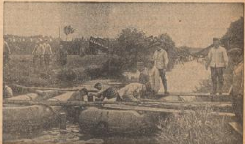
Deutsche Pioniere sind nach der Befreiung sofort an die Arbeit gegangen und bauen eine Straße bei Grotzky. Im Vordergrund die durch die Tschuschen zerstörte Straße. (Weiß-Gelmann, Jander-Multiplex-R.)
