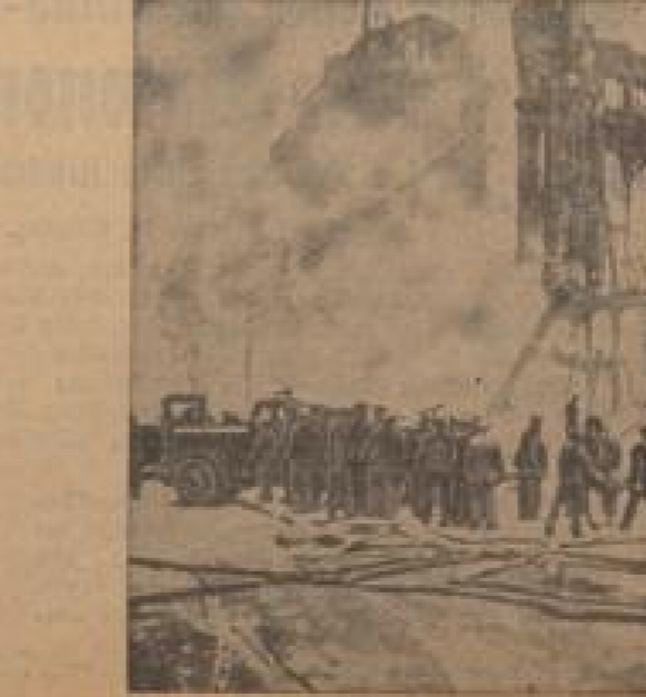
Die Polizei beginnt mit den Räumungsarbeiten. (Wiese-Ordnung, Stadt-Ordnung)
