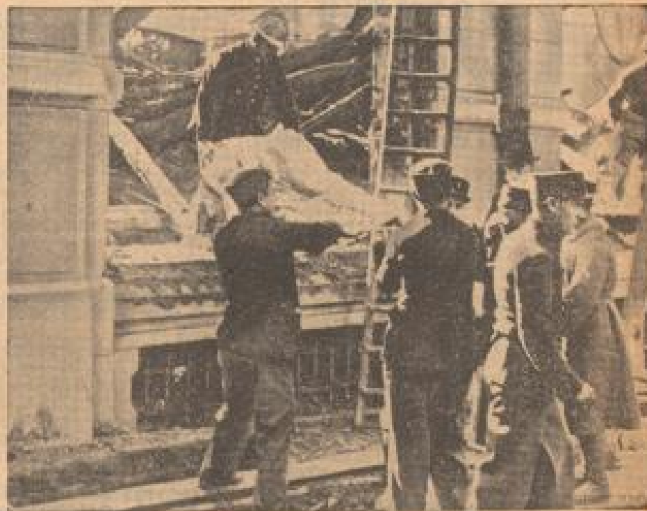
Aufräumungsarbeiten in der Gasse Die verfallenen Überreste der Häuser der Marceller Gasse werden von Wehrmacht- Männern abgetragen. (Wittlich, Sonder-Verlag-Dr.)
