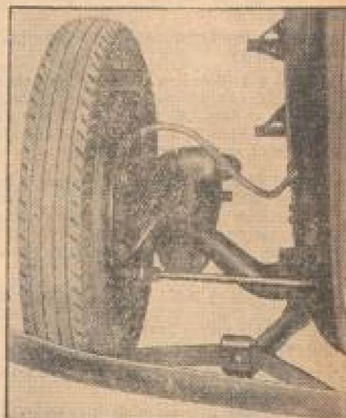
Vorderrad-Anhänger der Opel-Synchro-Federung, Modell 1935
