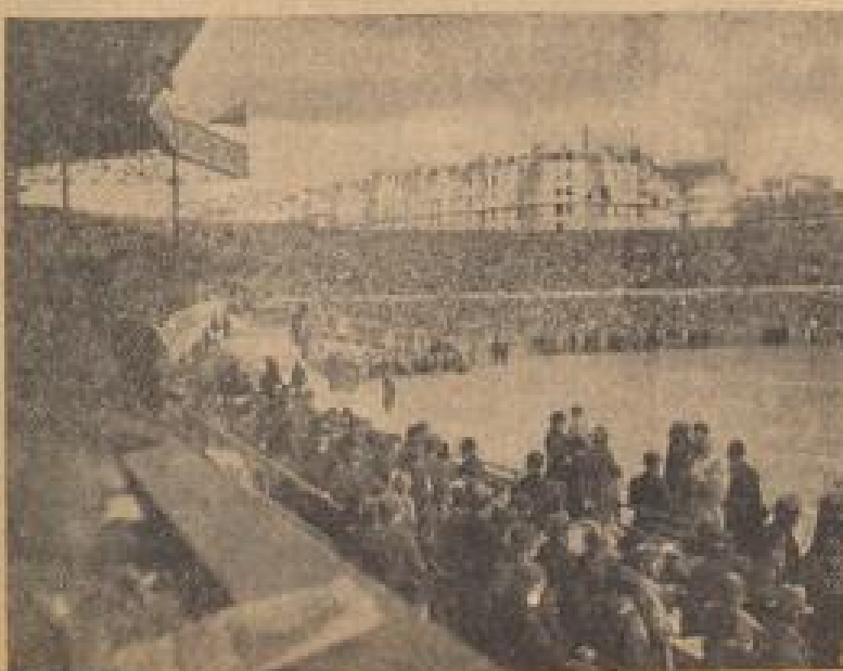
Blick von der Presstribüne ins Stadion
