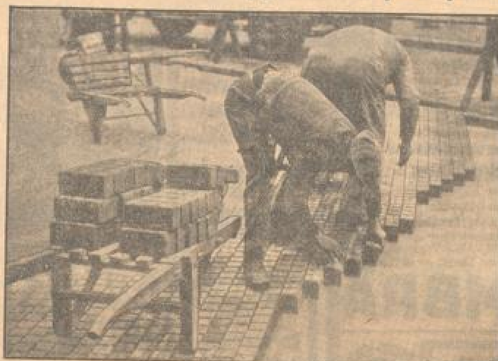
Europa-Abwehrdienst In Frankreich kommt es jetzt bevorzugt ein neuartiges Pflaster aus Ziegelsteinen gelangt, das einen vollkommenen Schutz der Straße und des Trottoirs ist. Im Falle der Beschädigung sollen die Pflasterer Strafen nach und nach mit diesem Pflaster gedeckt werden.
