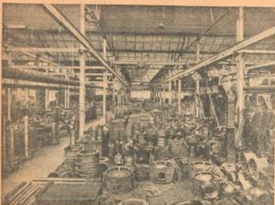
Blick in die Halle, in der Elektromotoren montiert werden
