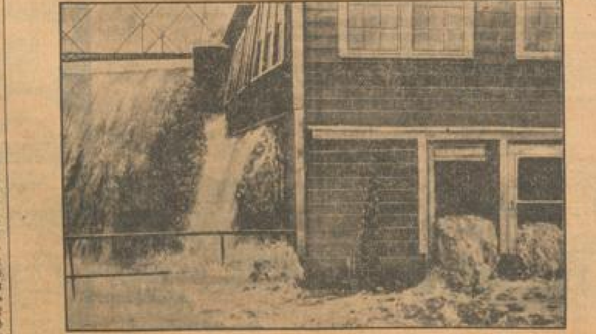
Die Einflut ergreift ein Quader. Die erdbeerrote Fassade von dem Reichsministeriumsgebäude in den nordwestlichen Winkel Mannheim. Die durch einen Zusammenstoß entfallenen Balken sind ein Zeichen für den Verfall und einen stark Quader.
