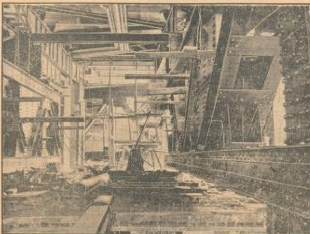
1000 Tonnen Eisenkonstruktionen liegen bei der Baustelle der U-Bahn bei der Brückstraße in Berlin, die von der neuen im Plan befindlichen Straße der U-Bahn durch den Untergrund führt. (Weidlich, M.)
