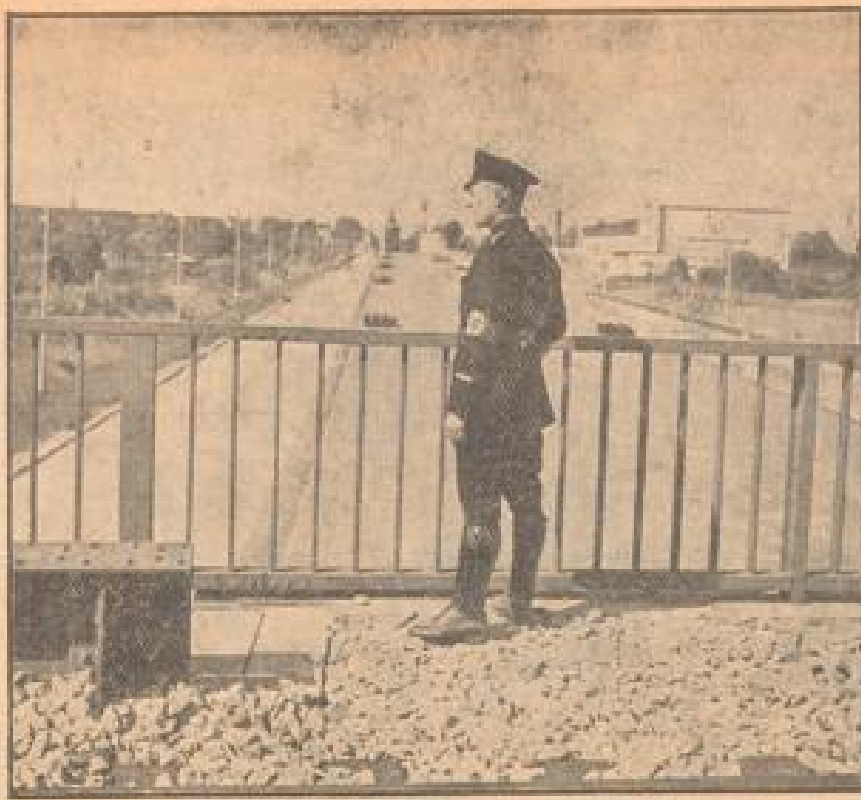
Jetzt bekommt der Streckenschutz erst recht zu tun!
