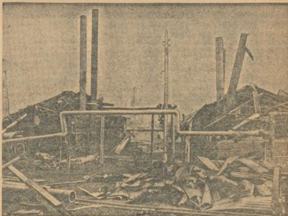
Schwere Petroleumexplosion in Moreni (Rumänien)
