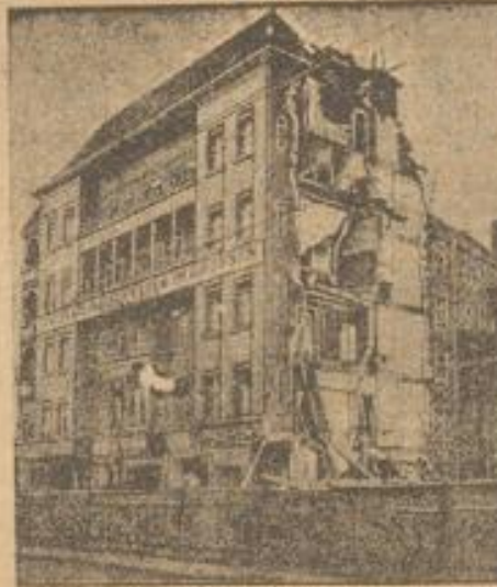
Das Explosions-Unglückshaus in der Landsbergerstraße droht jetzt einzustürzen
