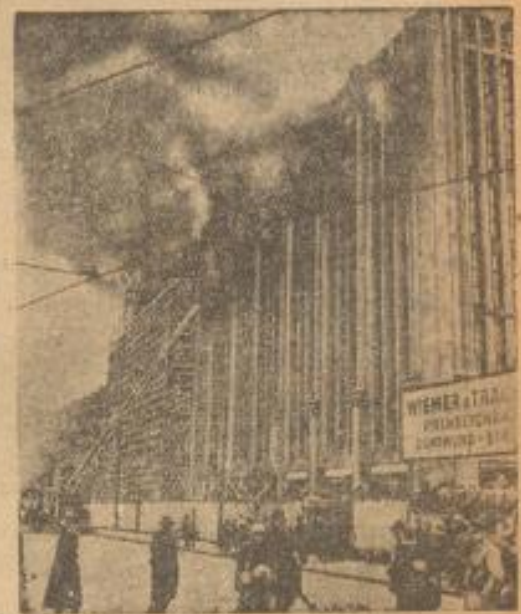
Großfeuer im Warenhaus-Neubau Karstadt in Neukölln
