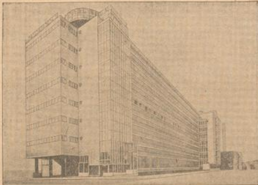
Eine Fabrik aus Glas
