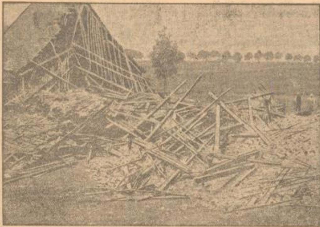
Eingekürztes Haus bei Straubing (Bayern). Ganz Deutschland war in den letzten Tagen von Unwettern schlimmsten Ausmaßes heimgesucht. Am meisten scheint Niederbayern unter der Katastrophe gelitten zu haben. Häuser stürzten ein, Felder wurden überschwemmt, harte Bäume über weite Strecken hin umgestürzt.
