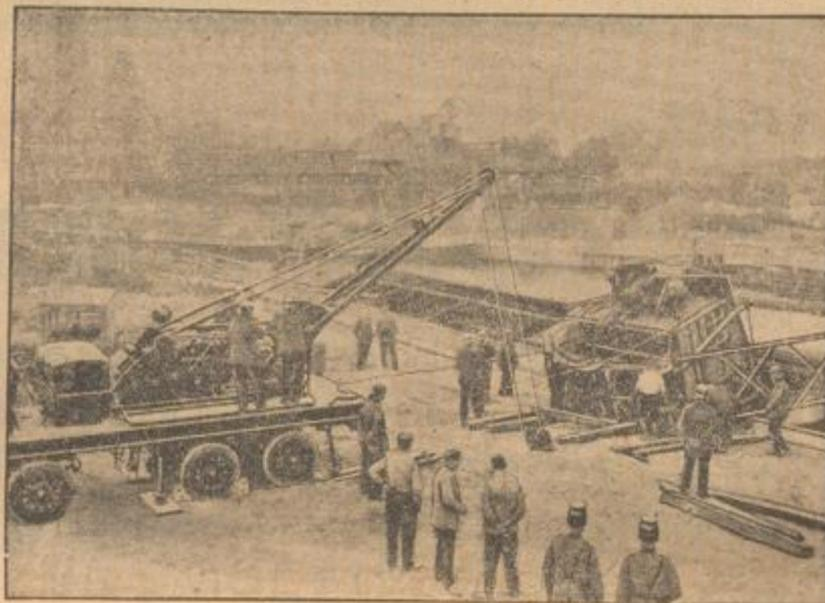
Die neue fahrbare Hebevorrichtung der Berliner Feuerweh konnte sich kürzlich bei einem merkwürdigen Unfall als außerordentlich brauchbar erweisen. Ein Kran war wegen zu großer Belastung auf einen Prachtbau gestürzt. In kurzer Zeit gelang es der Feuerweh mit der Maschine den gestürzten Kran zu heben. Unter Bild zeigt die Feuerweh bei der Arbeit.
