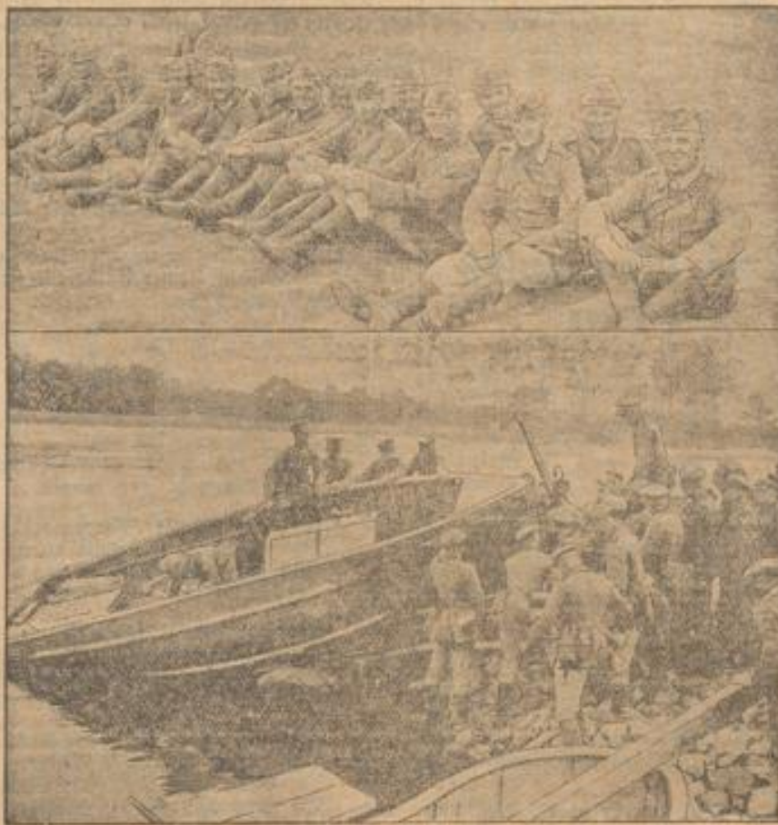
Oben: Plontersuppen mit der neuen Feldmütze der Reichwehr. Unten: Ein Ponton wird an Wasser gebracht. Bei Krenz an der Elbe finden zur Zeit die großen Plontiermanöver der Reichswehr statt. Die Übungen werden mit den modernsten Mitteln der Plontierkunst durchgeführt, wobei Motorpontons und Luftboote Verwendung finden.
