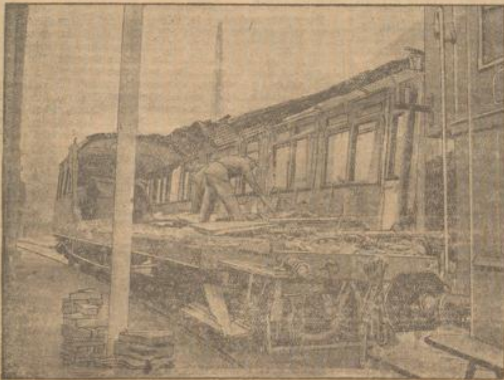
Die Eisenbahnfotografie auf der Tauroerabahn bei Naber 4 Opfer gefordert. Noch mehrere schwerverletzte Schwerverletzte in Lebensgefahr. Bei der Katastrophe blieben die aus allen getannten Dampfwagen fast unbeschädigt, während die Pullmowagen völlig zerstört wurden.
