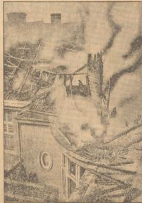
Ein Dachstuhlbrand am Kurfärstendamm in Berlin nahm einen in großem Umfang an, daß ein großer Teil der Berliner Feuerwehre den ganzen Tag über mit den Löscharbeiten beschäftigt war. Das Dach des Gebäudes stürzte in sich zusammen, wodurch das vierte Stockwerk und beinahe mehrere Feuerwehrtürme. Am ganzen Rand 7 Tote und 30 Schwerverletzte Opfer der Katastrophe geworden. Der Sachschaden ist außerordentlich hoch, da die Gebäude eines Hauptplatzes mit einer sehr wertvollen Ausstattung.
