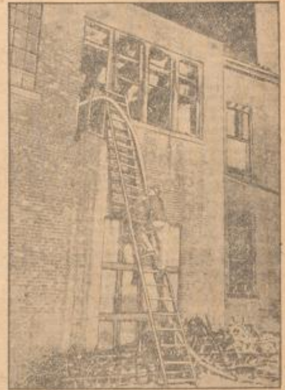
Die Rettungsaktion der Feuerwehr in dem Stadt-Club, einem Vergnügungslokal der amerikanischen Industriestadt Detroit, brach während des Nachtbetriebs ein Brand aus, der 16 Personen das Leben kostete, 50 Stühle wurden schwer verletzt.
