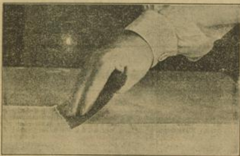
Das Spritzen (Glätten) der Flächen
