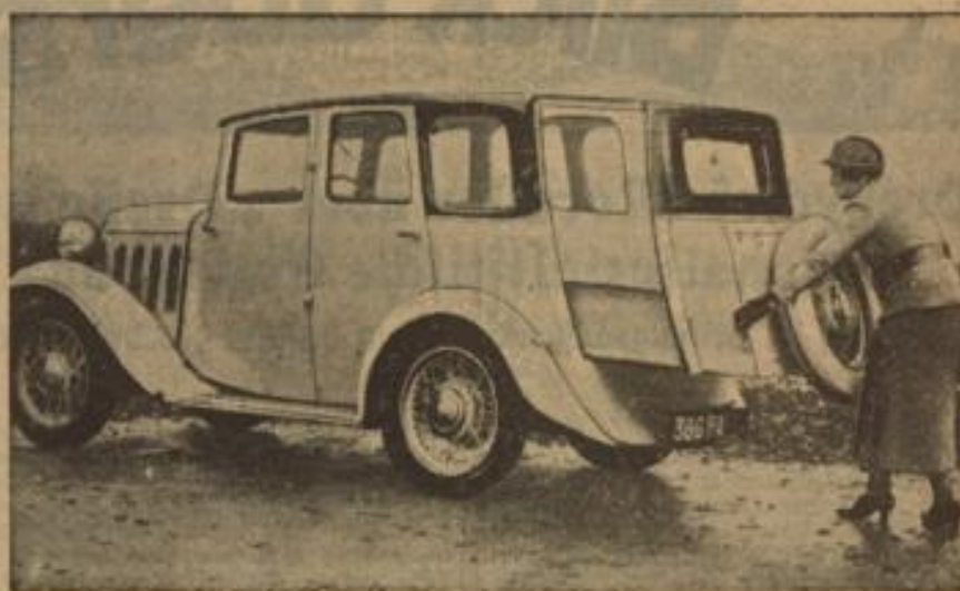
In England wurde ein sogenanntes „Caravan“-Automobil gebaut, das einem normalen Personenwagen gleicht, dessen Rückwand jedoch ausziehbar ist und durch eine festeren Konstruktion ein Bett, zwei Höcker und ein Nachschloß hervorbringt.
