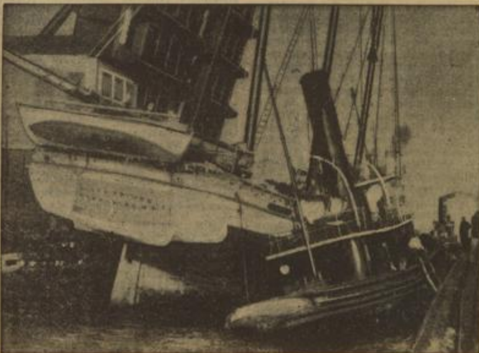
Ein seltsamer Schiffsunfall ereignete sich durch Senkung der Eisenbahnbrücke bei Reponset (Loas). Der Schoner „Mina Prince“ wurde mit einem Schleppdampfer an der Brückeneinfahrt so dicht zusammengedrängt, daß beide sich gegenseitig die Durchfahrt versperren, bis die Flut sie aus ihrer unangenehmen Lage befreite.
