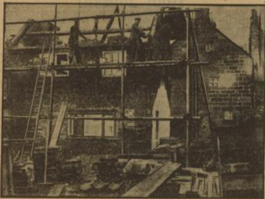
Die australische Regierung hat das Haus, aus dem Kapitän Cook seinerzeit als erster Weißer nach Australien ansawanderte, angekauft. In Riddlesborough (England) wird das Haus sorgfältig Stein für Stein abgerissen, um in Melbourne in der gleichen Weise wieder aufgebaut zu werden. Die Steine werden sogar nach einem genauen Plan mit Zahlen versehen.
