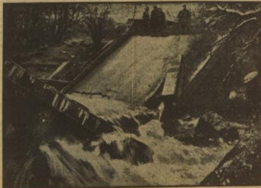
Die Aberarder-Brücke im Zuge der Landstraße von Ringville nach Fort William in Schottland stürzte infolge Senkung des mittleren Brückenpfeilers vollkommen ein und sperrte jeden Verkehr.
