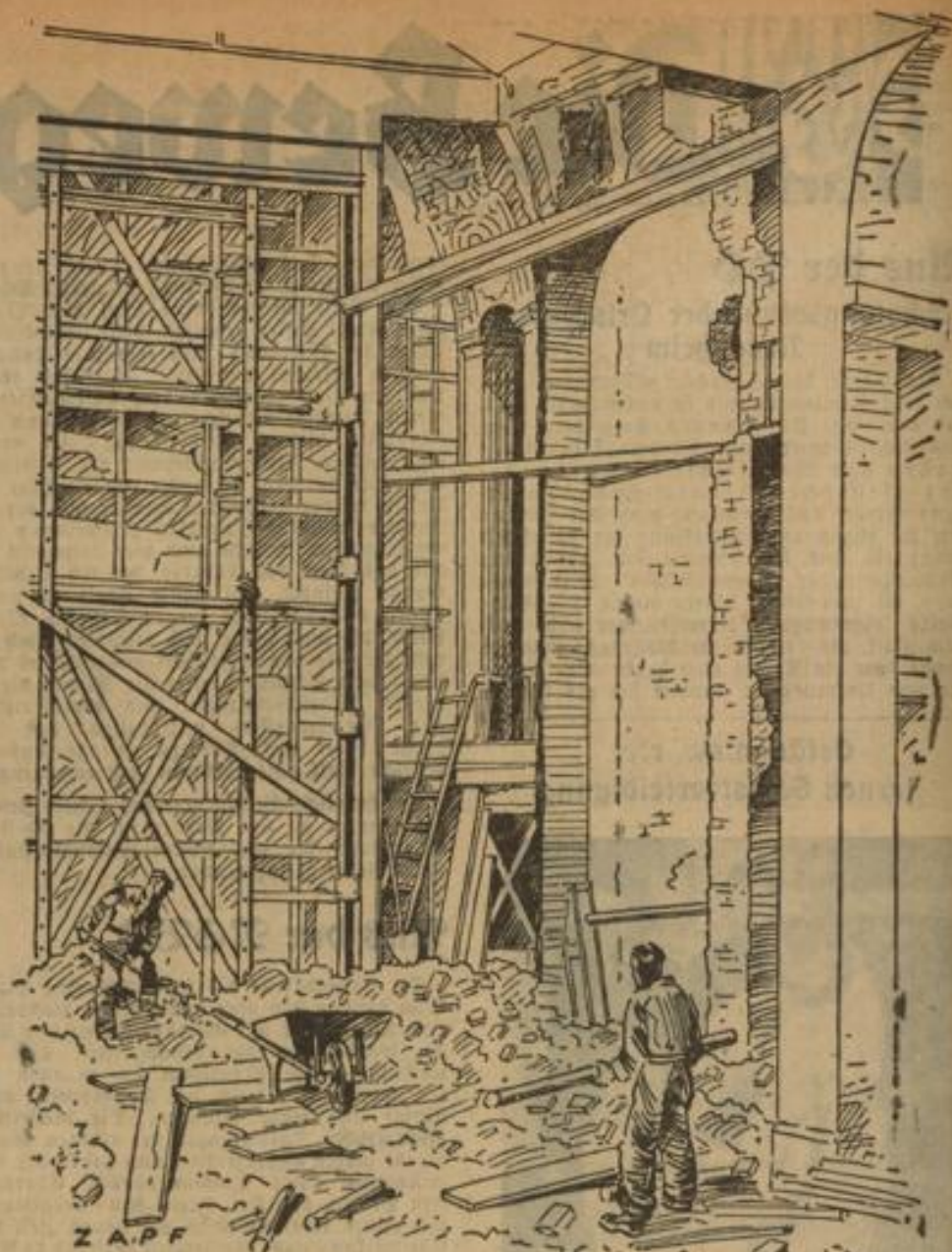
Blick vom Innern der Bühne dem Saal zu Die eigentliche Baustelle
