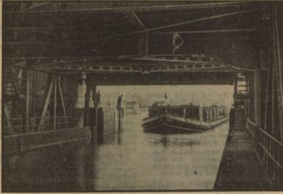
Einfahrt eines Schleppschiffes in den gigantischen Hebetrog, in dem fünf solcher Röhre gleichzeitig liegen können.
