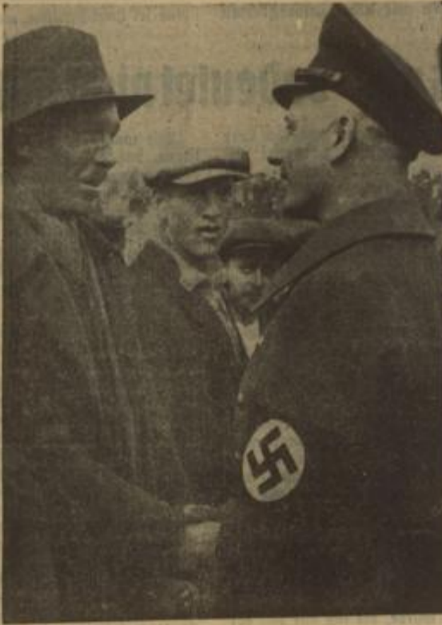
Der Reichsstatthalter Va. Robert Wagner im Gespräch mit einem neu eingestellten Arbeiter an der Baustelle am Dossenwald.
