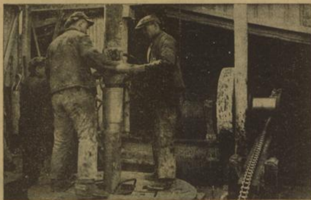
Im Bohrturm. Das Bohrgestänge wird verlängert
