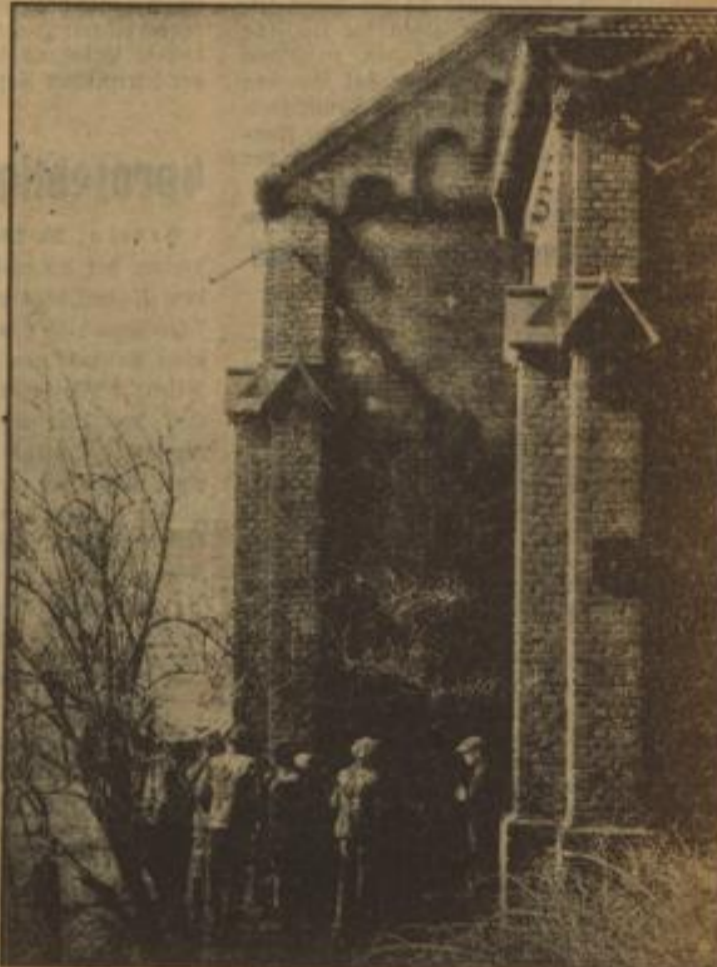
Die Kirche in Schnappach (Saar), die wegen der vom Schachtvortrieb der französischen Grubenverwaltung wegen Einsturzgefahr nicht mehr betreten werden darf
