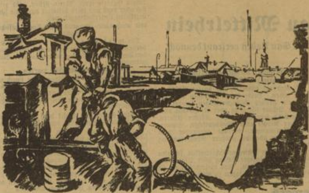
Mauerreste werden niedrigerissen
