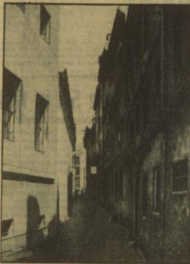
Ein vielen Einheimischen und Fremden lieb gewordenes Stück Alt-Berlin, der Krögel, wird in kürzester Zeit der Spitzhacke zum Opfer fallen, um modernen Neubauten Platz zu machen. In diesen Tagen werden sämtliche Häuser geräumt, und dann nehmen die Abbrucharbeiten ihren Anfang.
