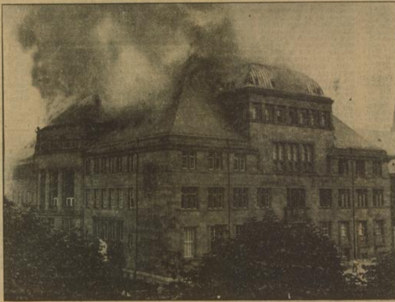
Das Freiburger Universitätsgebäude, das bis auf seinen östlichen Flügel zerstört wurde, während des Brandes. Die herrliche Kuppel ist eingestürzt.
