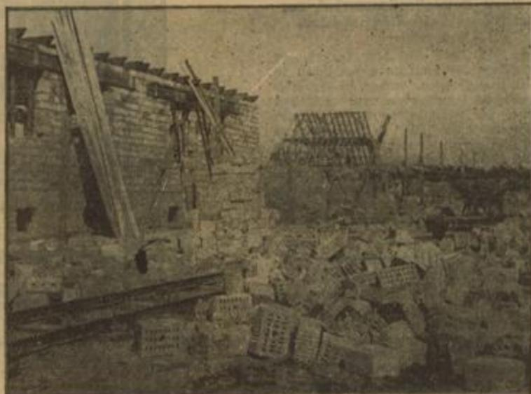
Während der Bauzeit - Die Balkenlage über dem Erdgeschoß liegt, teilweise sind die Dachsparren aufgeschlagen
