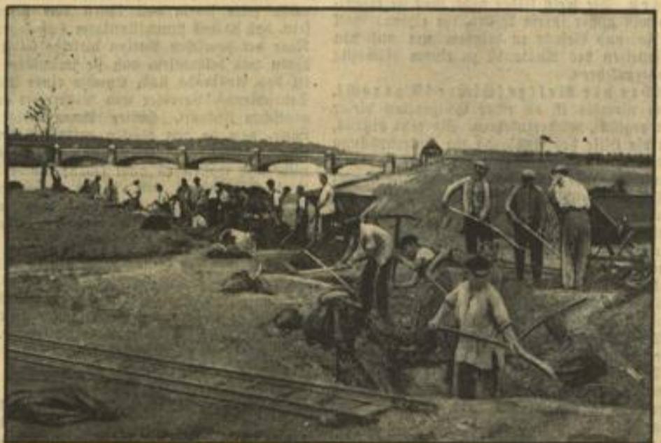
Ein Bild von der Baustelle in Leipzig, wo das Richard-Wagner-Nationaldenkmal des deutschen Volkes errichtet werden soll. Fleißige Hände sind bereits am Werk, den Raum für das Fundament zu schaffen
