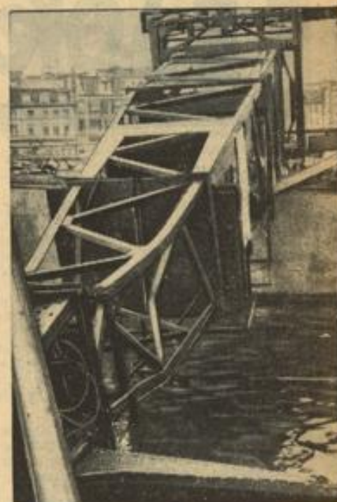
Auf dem Gelände des Reichsbahnbauwerkes in Berlin stürzte dieser Baukran um, nachdem er mit seiner Ladung festgefahren war, und legte sich quer über die Spree. Der Kranführer konnte sich rechtzeitig durch einen Sprung ins Wasser retten, so daß niemand zu Schaden kam.
