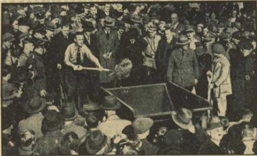
Auf der großen Berliner Ausfallstraße zwischen Wannsee und Potsdam führte Staatskommissar Dr. Lippert den ersten Spatenstich zur Abtragung des Kilometerberges aus. Mit dieser Arbeit wurde ein neues Stück im Rahmen des Arbeitsbeschaffungsprogrammes in Angriff genommen.
